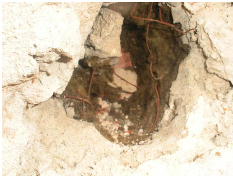
Fot. 1. Odkrywka – ściany zewnętrzne istniejąca warstwa ocieplenia
