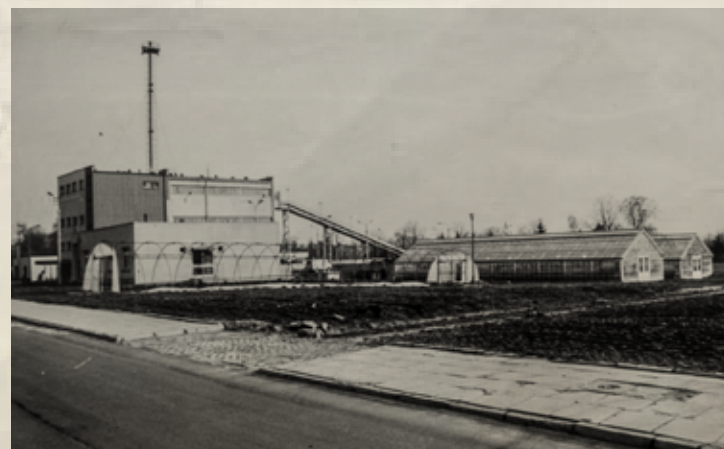
Widok na kotłownię, Laboratorium
