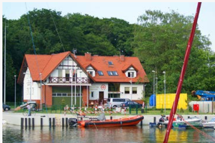
Zmodernizowany port rybacki w Tolkmicku
