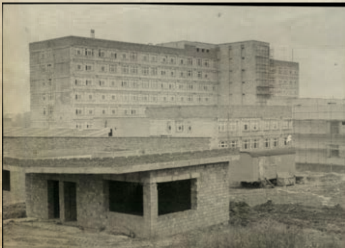
Stan surowy fot Piotr Kajmer
