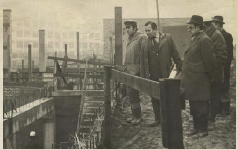
Władze miasta kontrolują przebieg prac na budowie
