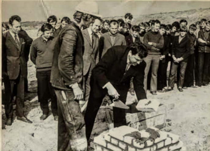
8 lutego 1975. Wmurowanie kamienia węgielnego pod budowę nowego szpitala. Na pierwszym planie przewodniczący MRN w Elblągu Bolesław Smagata
