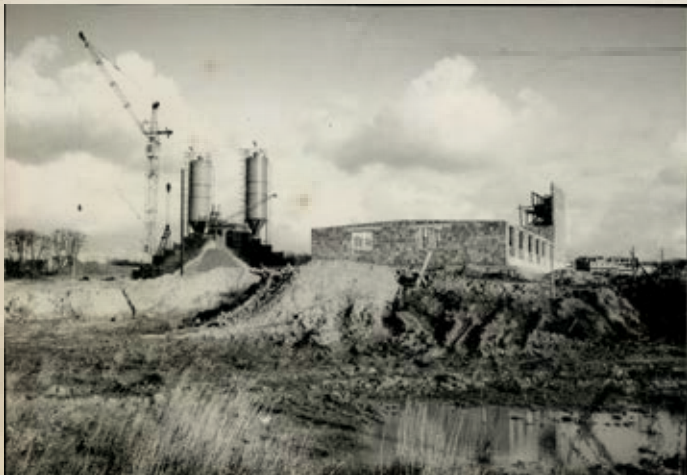
Początki budowy szpitala. Fot Czesław Misiuk
