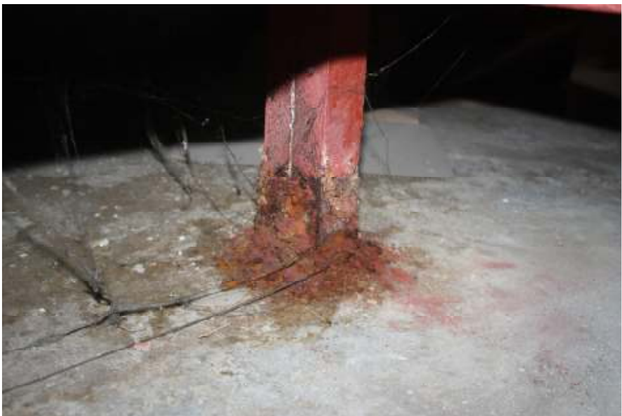
28. Część techniczna tunelu - konstrukcja stalowa podłogi technicznej, słup podpierający element stalowy w osi podłużnej kanału - rejon zakotwienia w żelbetowej płycie dennej tunelu
