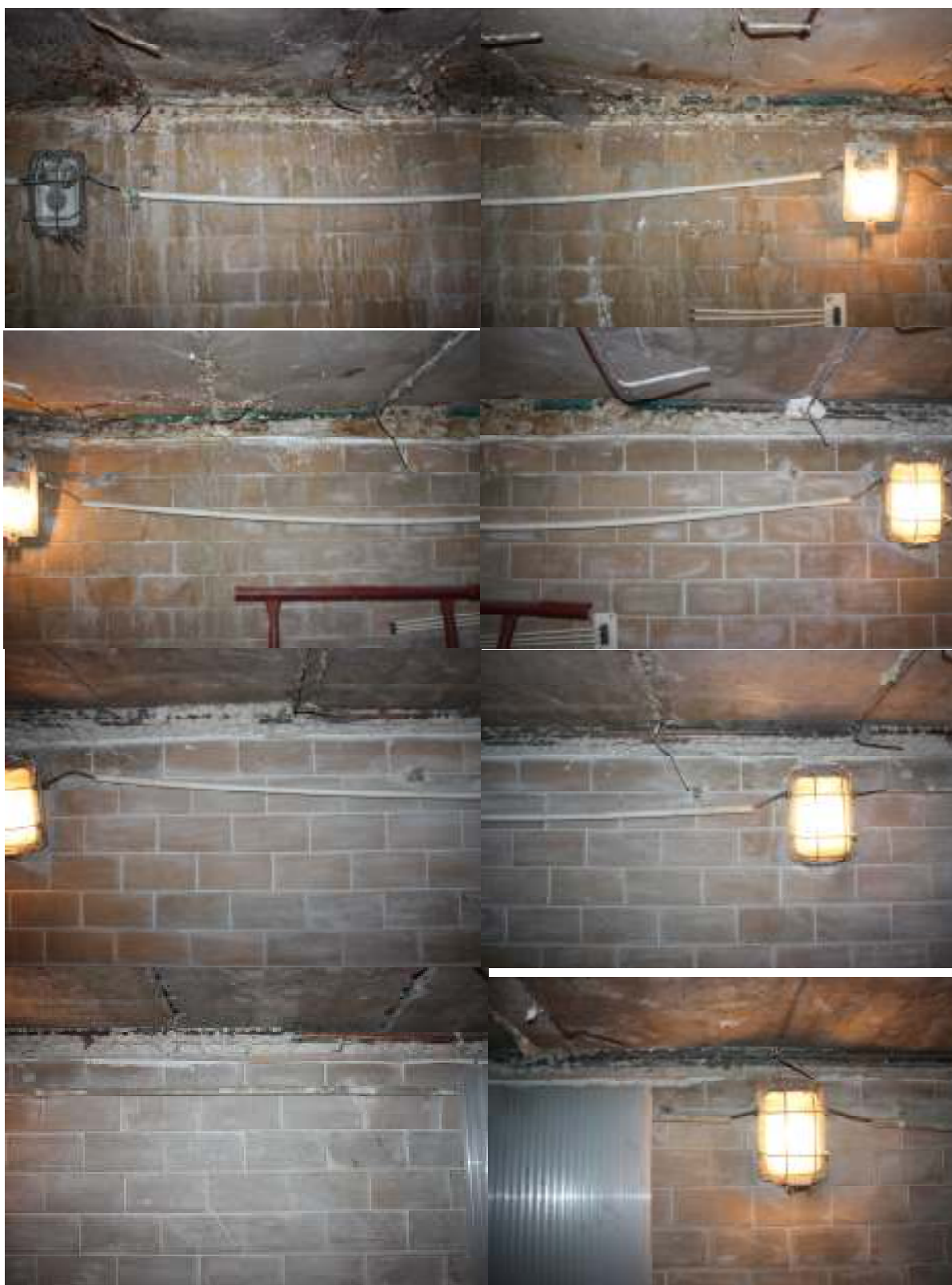
9-10-11-12-13-14-15-16. Ściana PN-ZACH - fotografie odcinków strefy górnej - rejon styku okładziny ceramicznej ścian z płytami stropowymi
