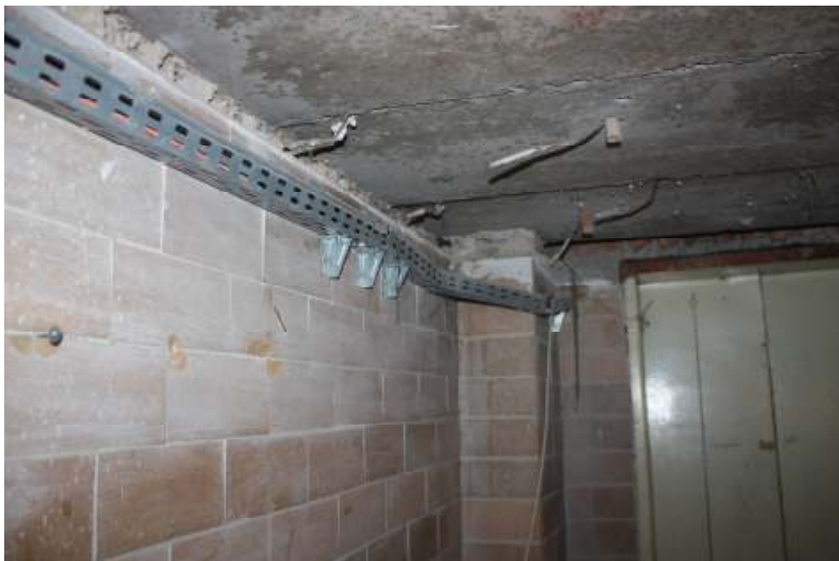
1. Ściana PD-WSCH, prefabrykowane żelbetowe płyty stropowe - przekrycie tunelu - widok w kierunku drzwi - wejścia do Budynku B
