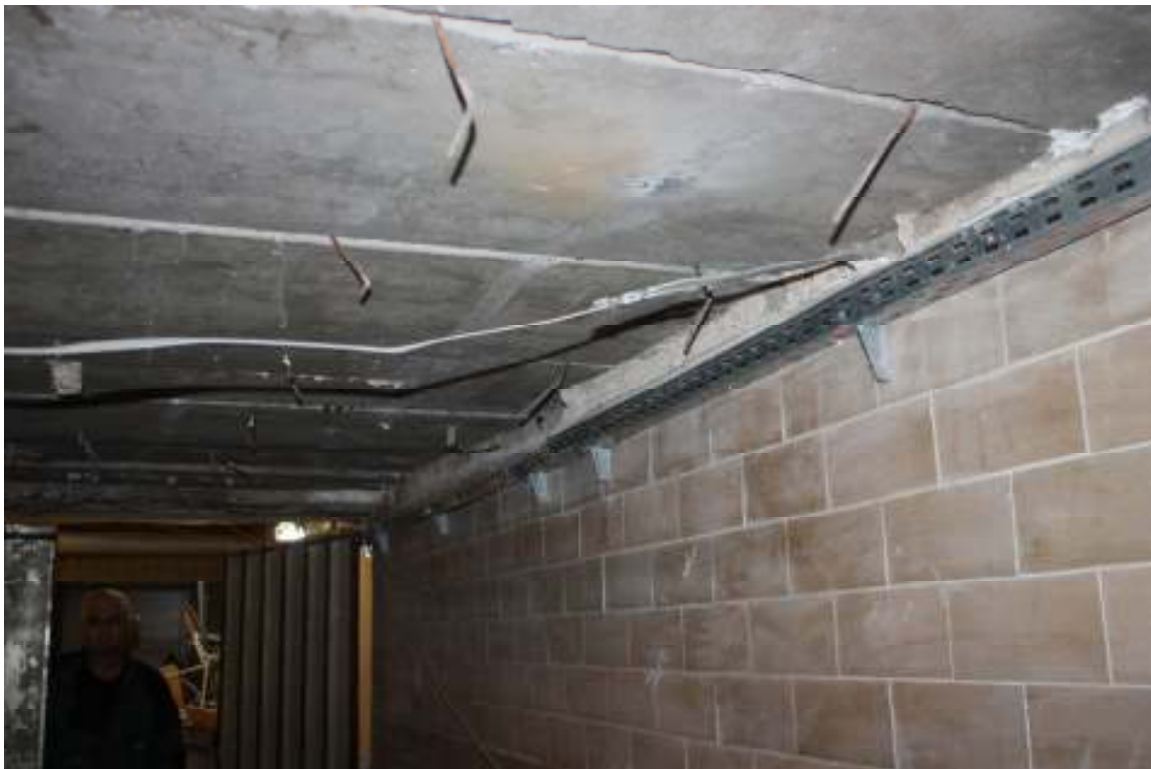
17. Ściana PD-WSCH, prefabrykowane żelbetowe płyty stropowe - przekrycie tunelu - widok w kierunku kraty/bramy stalowej - wejścia do Budyńku P+K
