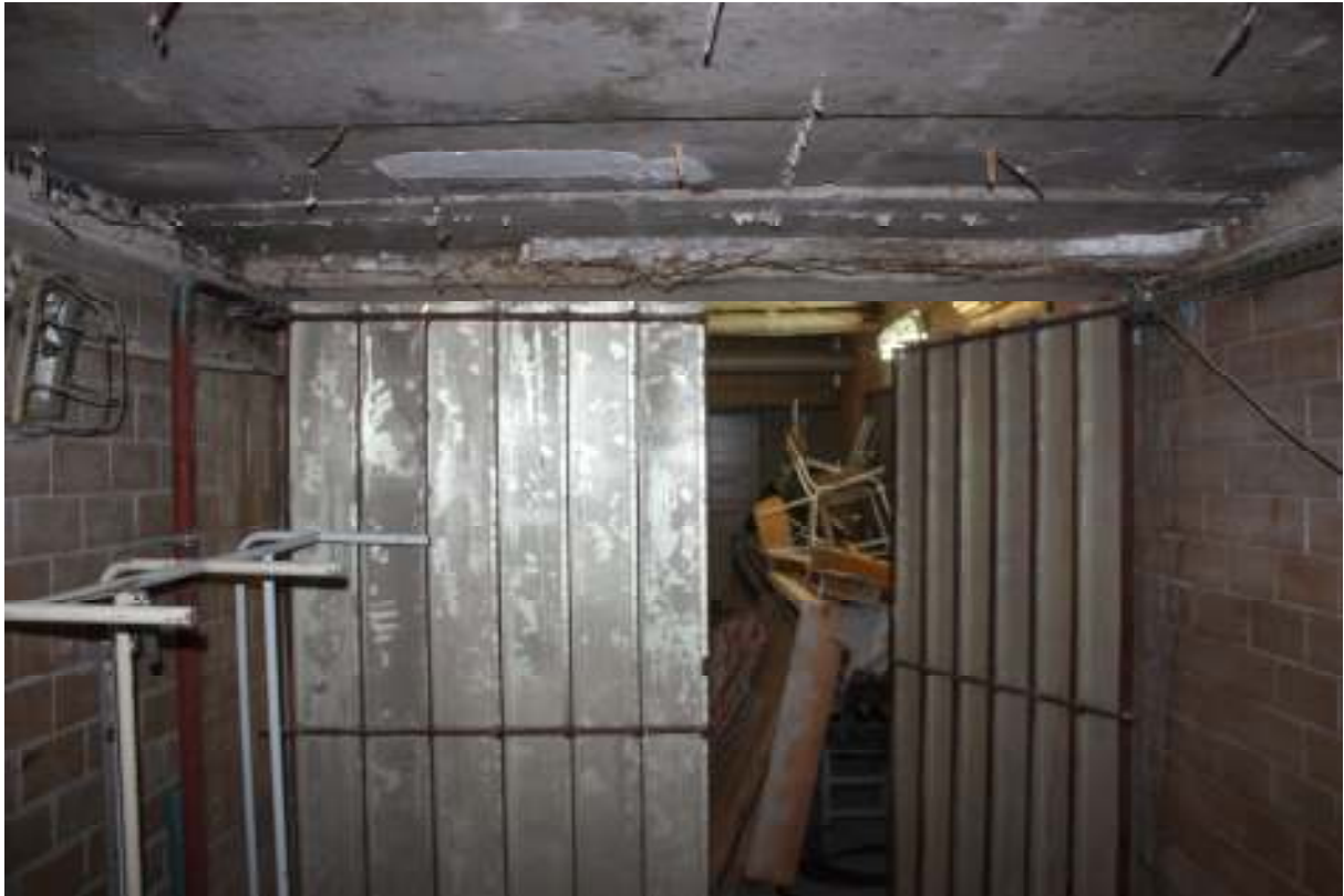
3. Ściana PN-WSCH, prefabrykowane żelbetowe płyty stropowe - przekrycie tunelu - widok w kierunku kraty/bramy stalowej - wejścia do Budynku P+K
