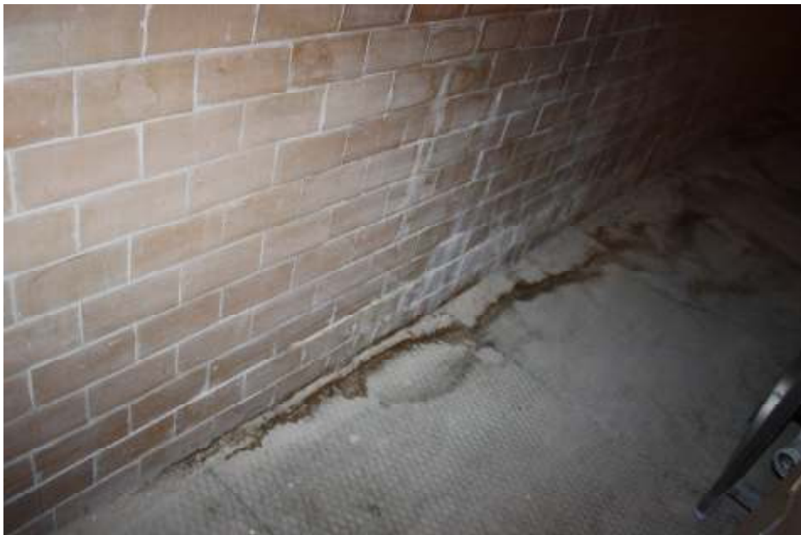
18. Ściana PD-WSCH, podłoga techniczna ze stalowych blach ryflowanych - rejon styku stalowych blach ryflowanych podłogi technicznej z okładziną ceramiczną ścian
