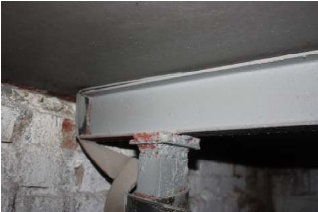
27. Część techniczna tunelu - konstrukcja stalowa podłogi technicznej, słup podpierający element stalowy w osi podłużnej kanału
