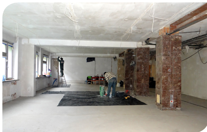
Sala konferencyjna w trakcie remontu
