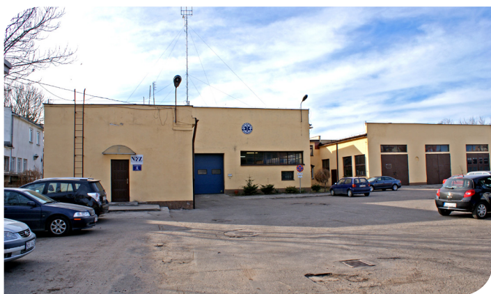
DRM przed remontem
