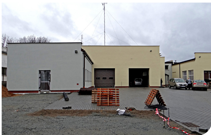
DRM w trakcie remontu
